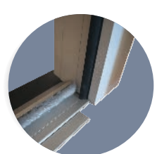
Détail joint et seuil
